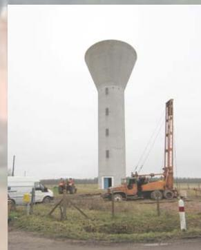
Le premier forage - réalisé en 1966 - est d'une profondeur de 60 m, d'un diamètre de 580 mm. Le second forage datant de 1976 présente un diamètre de 1050mm au niveau du sol et de 610mm à 60 mètres plus bas. L'eau y est douce et peu minéralisée ce qui est normal pour un aquifère sablo - argileux. De plus, ses caractéristiques physico-chimiques et bactériologiques sont bonnes, ce qui en fait une eau potable et appréciée de chacun d'entre nous.
