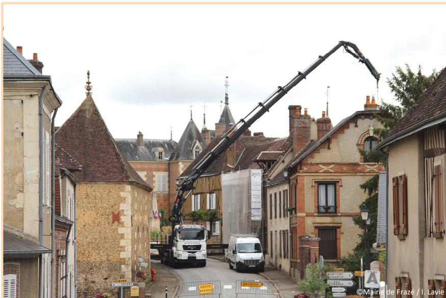
Après quelques semaines d'arrêt en raison du confinement, les travaux ont pu reprendre. On aperçoit maintenant la charpente en bois du préau à l'arrière des bâtiments donnant sur la rue. Cette structure composée de pièces de bois découpées et prémontées en atelier a été apportée par grue. Impossible en effet d'entrer dans la parcelle avec un véhicule, les accès sont trop étroits, que ce soit rue du 8 Mai 1945 ou rue du 19 Mars 1962.
