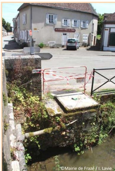
D'autre part, il s'agit du mur de soutènement situé en contrebas de l'ancienne cabine téléphonique, qui sous l'effet du creusement par l'eau du bief menace de s'effondrer.
